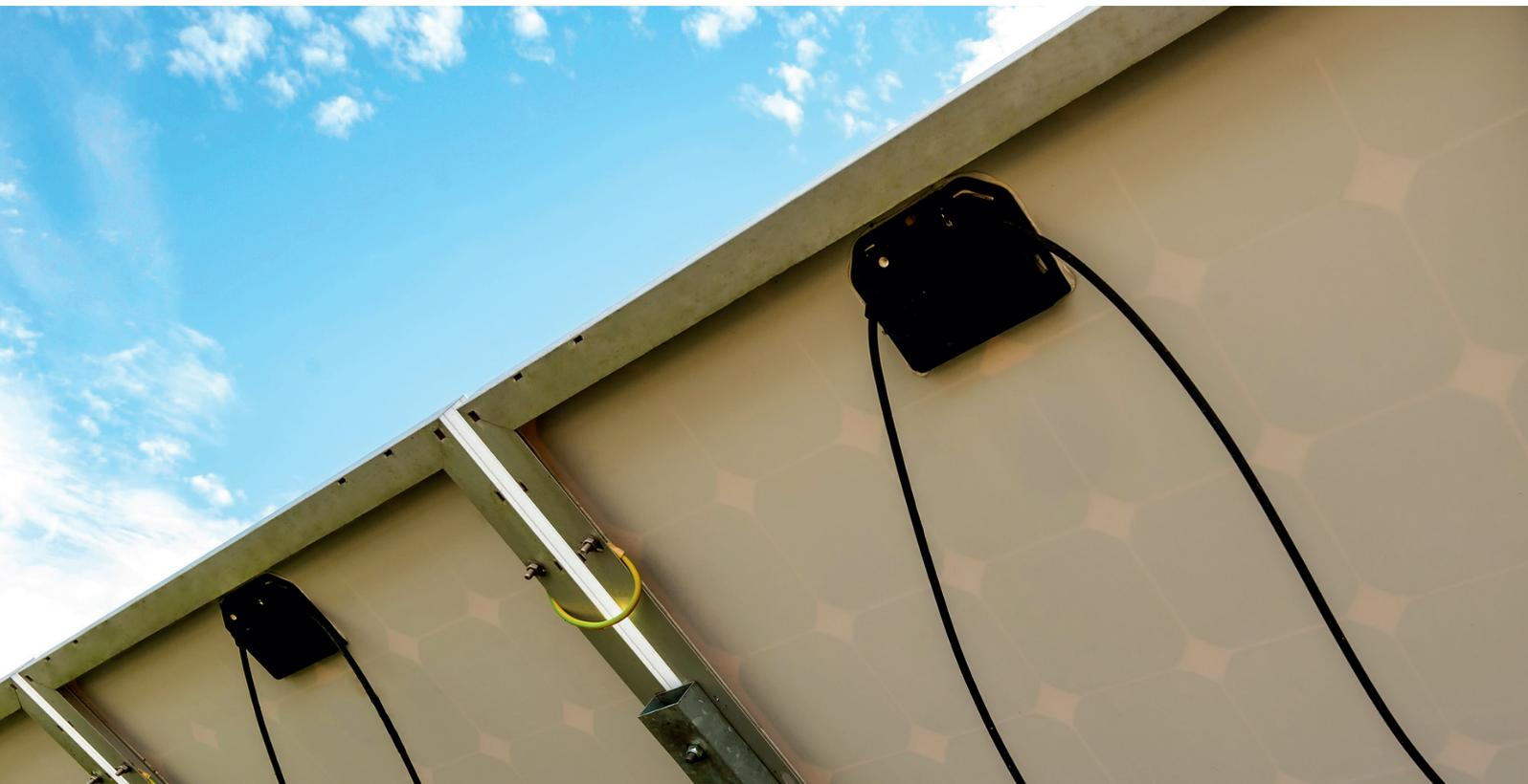
Die elektrischen Kontakte und Verbindungen innerhalb der Anschlussdosen hängen von der Konstruktion bzw. der Dichtheit der Dose selbst ab.
