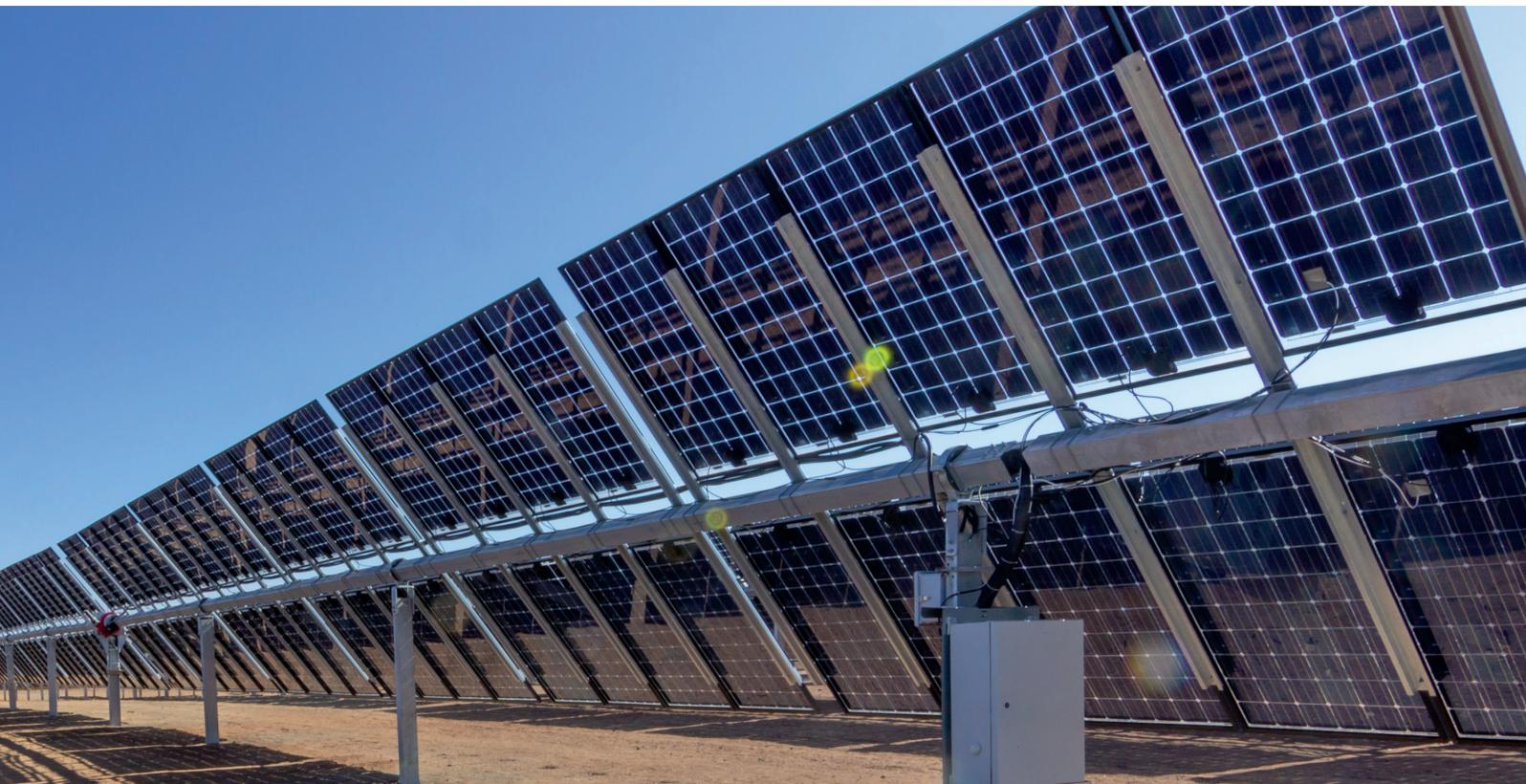
Herkömmliche Module und deren Befestigungsstellen bzw. Befestigungssysteme werden durch zusätzliche Profile an der Modulrückseite ergänzt, wenn es um rahmenlose Konstruktionen zum Beispiel in Solarparks geht. Für eine einfachere Installation der fertigen Paneele verbessern die Modulhersteller ihr Befestigungssystem, indem sie im Back-End-Bereich der Produktionslinie Stützschiene an ihren Modulen verkleben.
