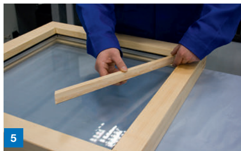
5 Einbringen der Glashalteleiste
