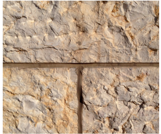
Abdichtung mit Dichtstoff und PE-Rundschnur
