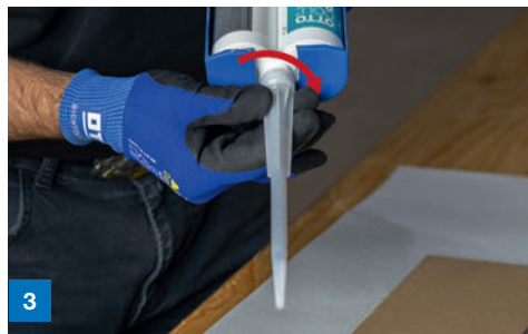
Material abwischen und Statikmischer aufschrauben
