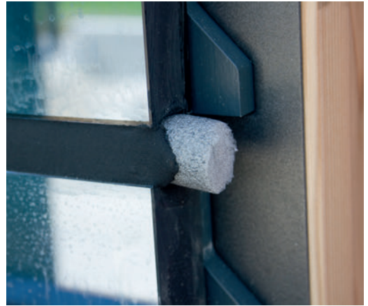
Abdichtung mit Dichtstoff und PE-Rundschnur
