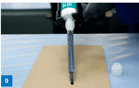
9 Raupenaustrag und Homogenität der Mischung prüfen (siehe Verarbeitungsbegleitende Qualitätskontrollen 2K-Produkte)
