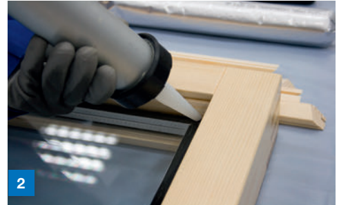
2 Abdichtung am Flügelrahmen hinter der Glashalteleiste
