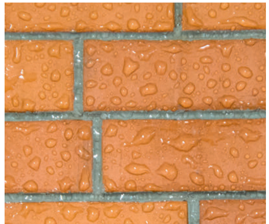
Hydrophobierte Fassade mit OTTO Siloxan 290L
