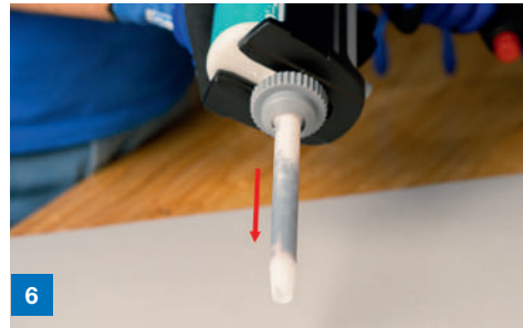
6 Befüllen des Statikmischer mit Klebstoff. Homogenität der Mischung prüfen (siehe Verarbeitungsbegleitende Qualitätskontrollen 2K-Produkte)
