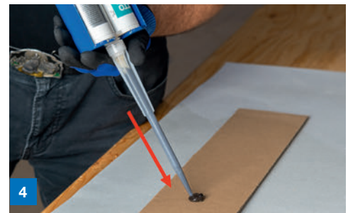
Befüllen des Statikmischer mit Klebstoff und Homogenität der Mischung prüfen (siehe Verarbeitungsbegleitende Qualitätskontrollen 2K-Produkte)
