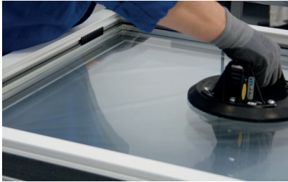
Einlegen der Glasscheibe
