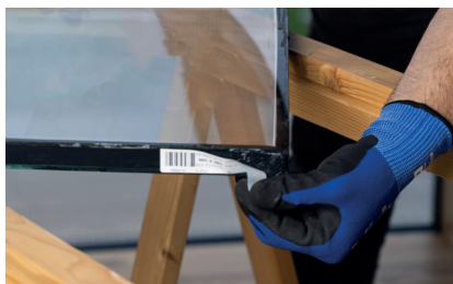
Entfernen von Aufklebern vom Isolierglas
