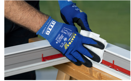
Vorbehandlung der Klebfläche des Profils mit OTTO Cleanprimer (bzw. Cleaner + Primer) 1)
