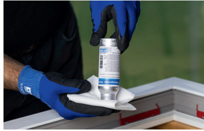
Benetzen des Tuches mit OTTO Cleanprimer (bzw. Cleaner + Primer) 1)
