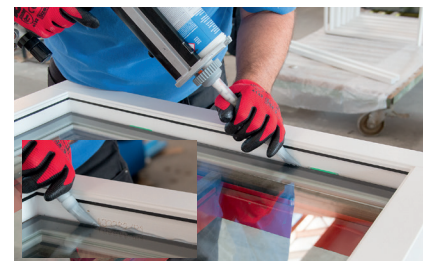
Befüllen des Falzgrundes mit Klebstoff
