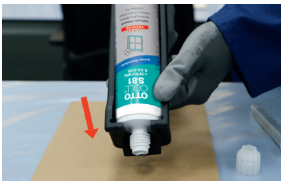
Einlegen der Koaxial-Kartusche in die Pistole von oben (Toplader)
