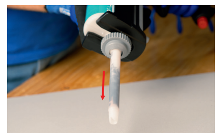
Befüllen des Statikmischer mit Klebstoff. Homogenität der Mischung prüfen (siehe Verarbeitungsbegleitende Qualitätskontrollen 2K-Produkte)
