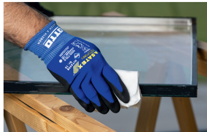
Reinigung des Randverbundes mit OTTO Cleanprimer (bzw. Cleaner + Primer) 1) und Stofftuch
