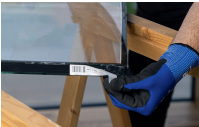
Entfernen von Aufklebern vom Isolierglas
