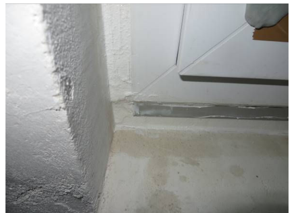
Bild 6 Eckausbildung der Abdichtung raumseitig unten
