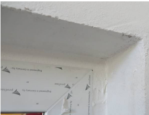
Bild 3 Eckausbildung der Abdichtung, außen oben
