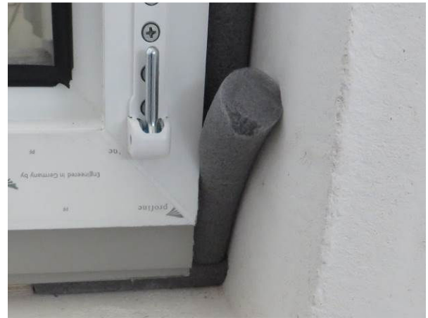
Bild 2 Detailansicht Hinterfüllung der Dichtstofffugen
