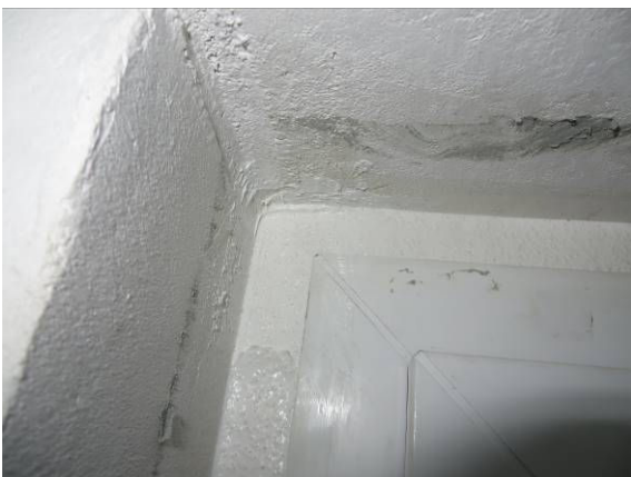
Bild 5 Eckausbildung der Abdichtung, raumseitig oben
