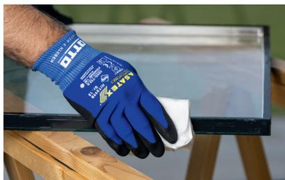
Nettoyage du mastic avec OTTO Cleanprimer (ou Cleaner + Primer)<sup>1)</sup> et un chiffon en tissu
